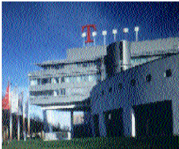
Telekom-Zentrale in Bonn: „Großunternehmen hätten Probleme, wenn wir plötzlich einen Überschuß unterbringen sollten.“
